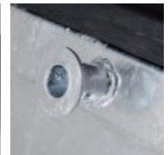
Hoisting pins
